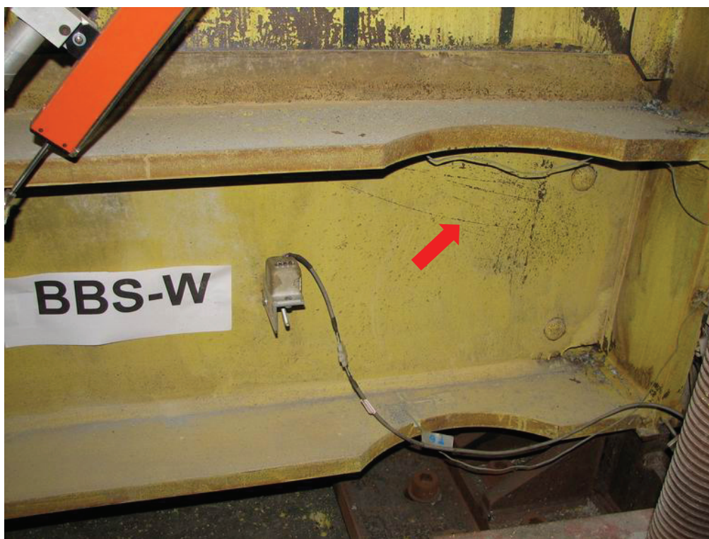
(d) South End of the Bottom HBE – West Side
