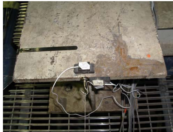
(d) SE Corner
