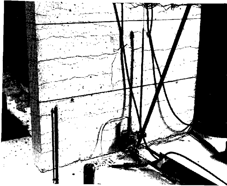
Fig. B-173 Cracking Pattern in Flange of Specimen F1
