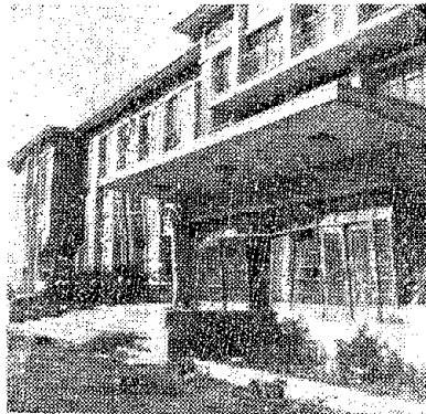
图13 10度区唐山第一瓷厂办公楼雨罩震后状态
