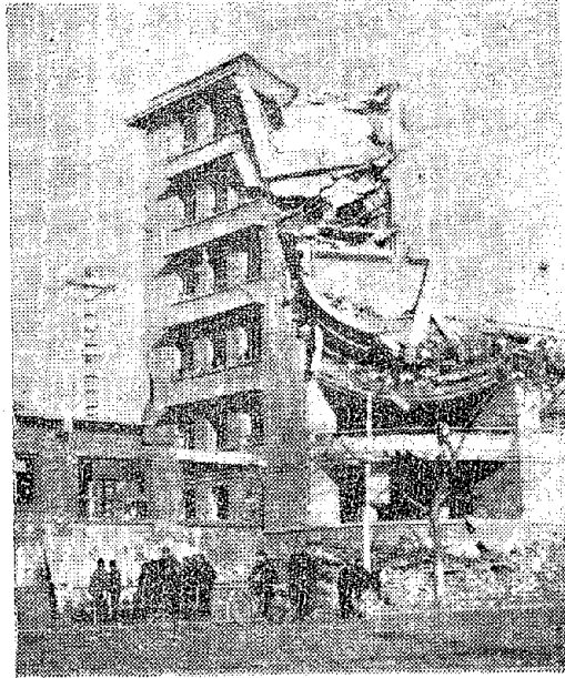
图17 震后开滦总医院转角楼部位残存
