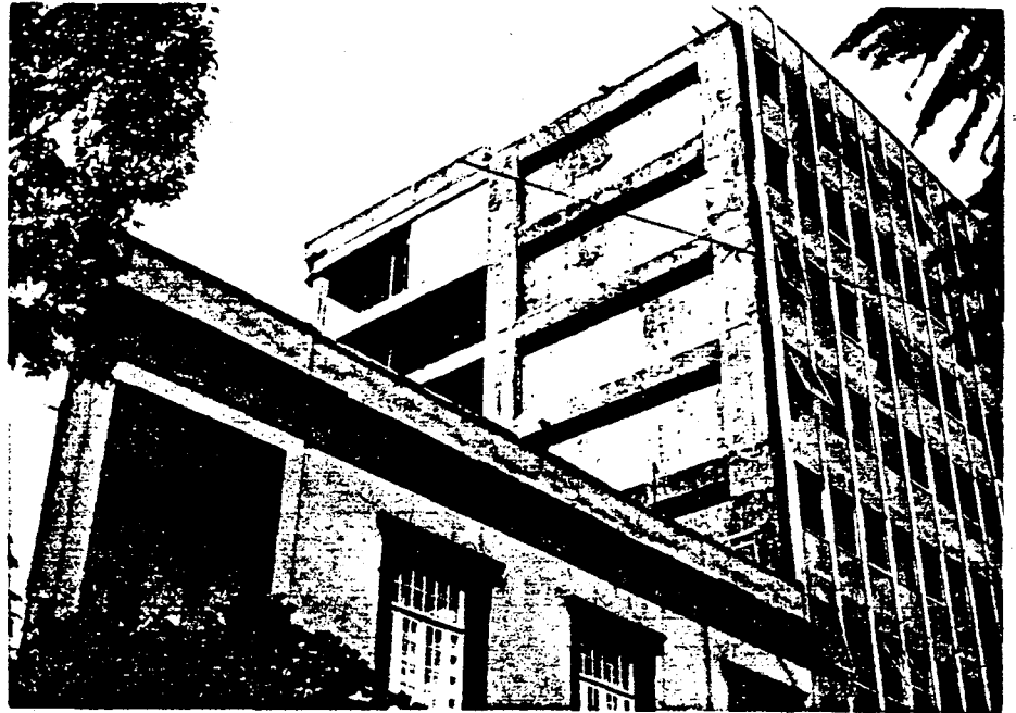
Muro De Cortante En Colindancia Usando Unicamente Un Entreje En Pisos Superiores
