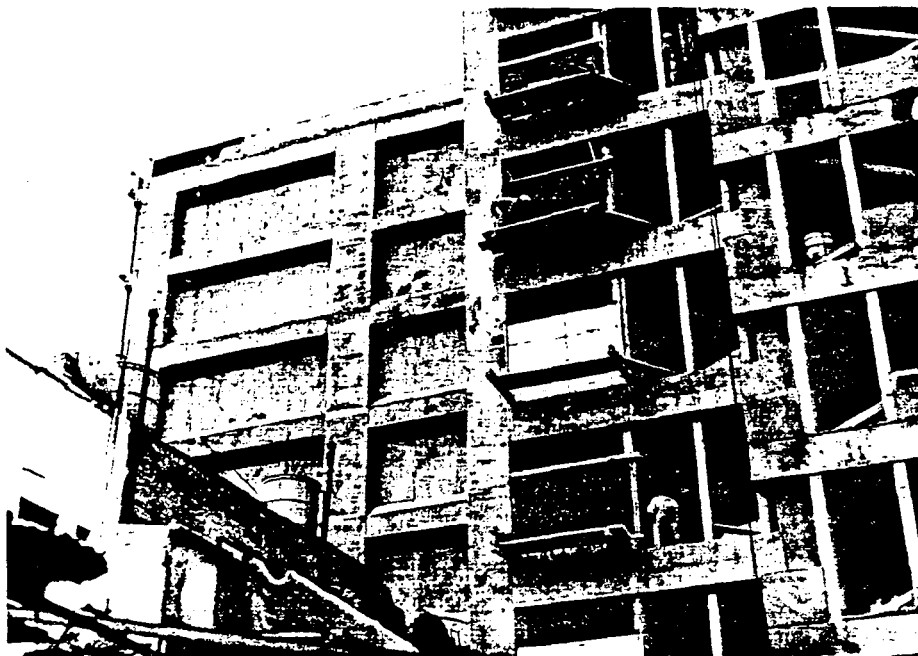
Muros De Refuerzo En Colindancia
