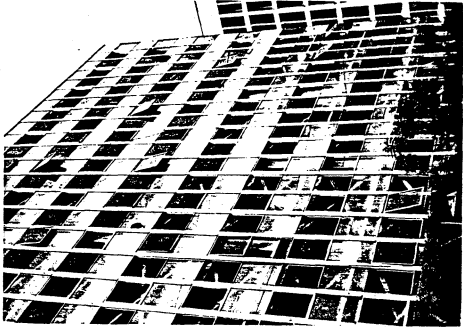
Fachada Original Con Crucetas Al Interior
